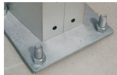
Pylonerne kan som tillæg leveres med en fodplade. Her et eks., hvor pylonen er monteret på et beton fundament med nedboret gevindstang /klæbeanker.
